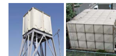
⑨高置水槽・受水槽リニューアル
