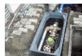
①給水・給湯配管更新工事
