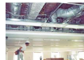
④照明システム天井改修工事
