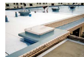
防水工事（屋上）
