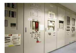
⑧防災設備
