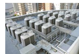
⑦空調和設備
