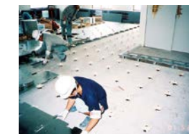
⑤OAフロア設置工事
