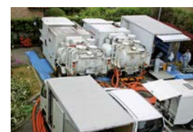
④排水管更生工事
