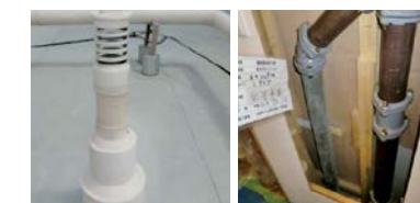
⑥排水・通気設備更新
