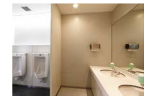
⑥トイレ改修工事
