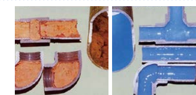
③給水管更生工事（施工前・施工後）
