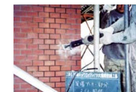
タイル貼り替え工事
