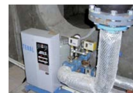
⑤給水・給湯装置（ポンプ）改修工事
