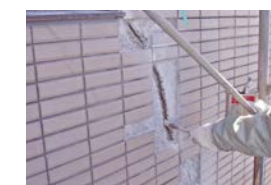
下地補修工事・シーリング工事
