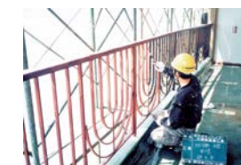
塗装工事（鉄部塗装）
