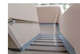
廊下・階段（長尺シート貼り工事）
