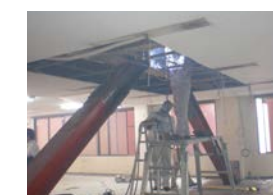
⑧-1耐震改修工事
