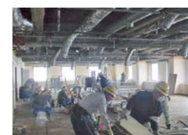
⑦解体工事
