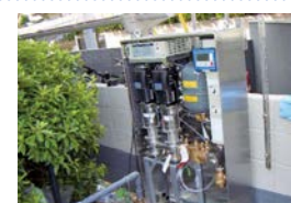
②給水システム変更工事
