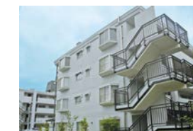
塗装工事（外壁塗装）
