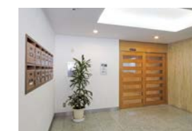
エントランス・自動ドア設置
